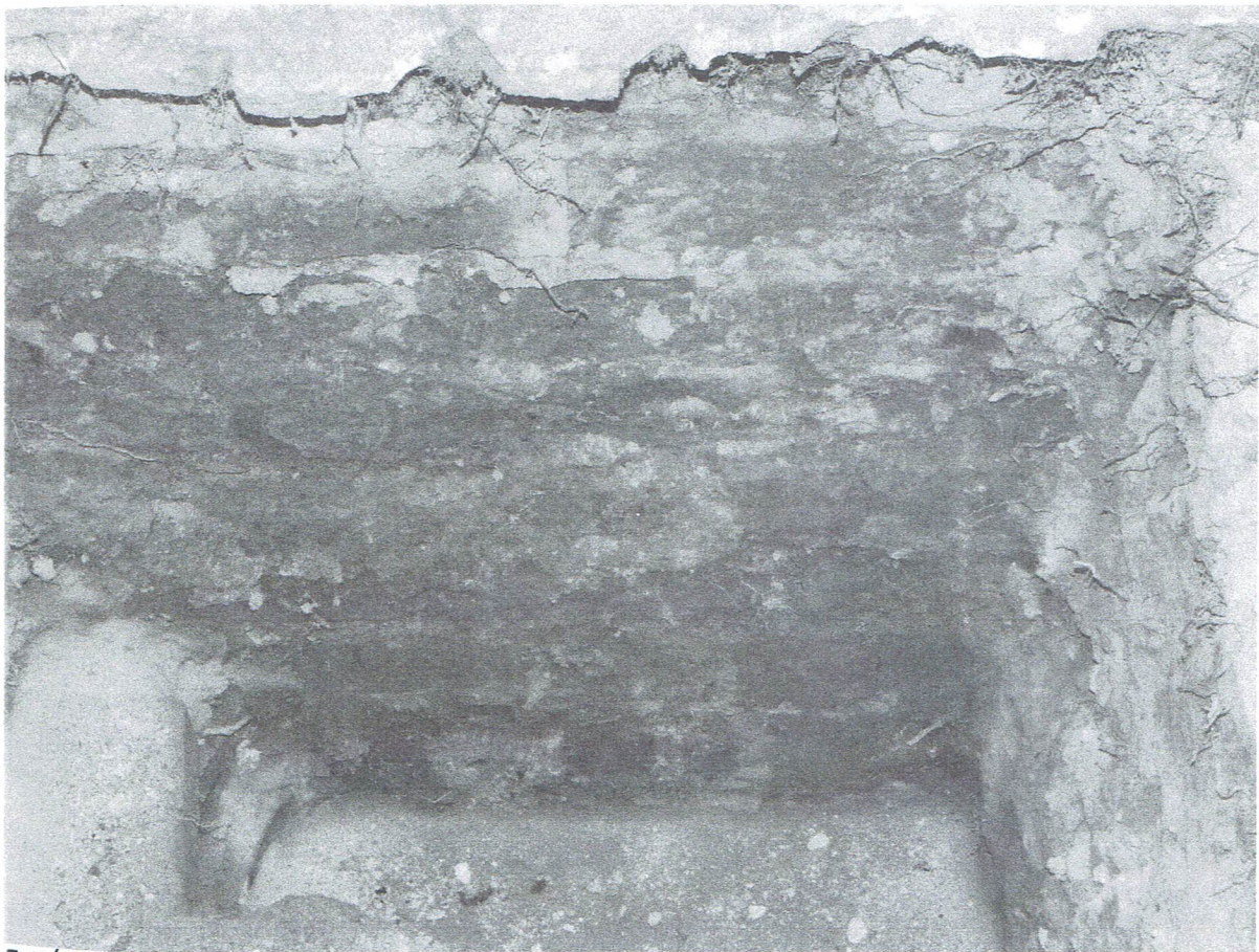
Fot. Ściana fundamentowa
